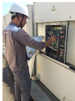
空調設備保守点検の様子
