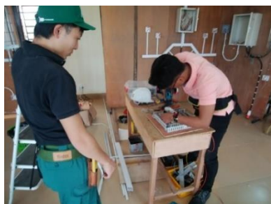
配電盤の作業風景
